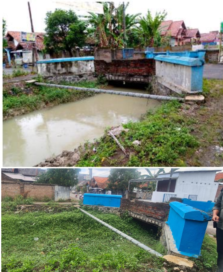
Gambar 35 Lokasi Jembatan Pipa Bentang 5 m
